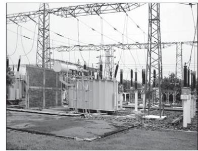
**Gambar 5.24** Sebuah unit pengubah tegangan (transformator) yang digunakan PLN.
