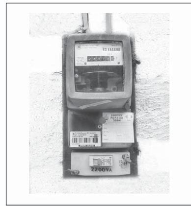
**Gambar 6.16** Salah satu jenis kWh meter yang digunakan untuk mengukur penggunaan energi listrik oleh konsumen.
