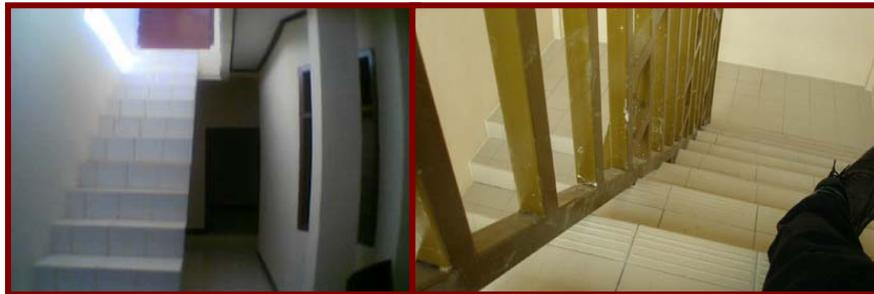
Gambar VI-5, Pemasangan Keramik Pada Konstruksi Tangga
