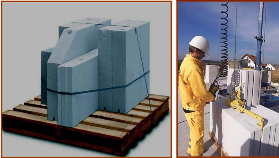
Gambar IV-7. Bata Hebel Dan Pengerjaan Bata Hebel.
