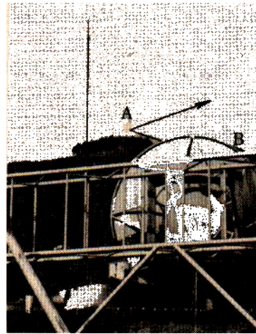
Gambar 5-90. Reflektor Pasif (A) dan Antena Parabola (B) Gelombang Mikro (Panah menunjukkan Lintasan Gelombang)
