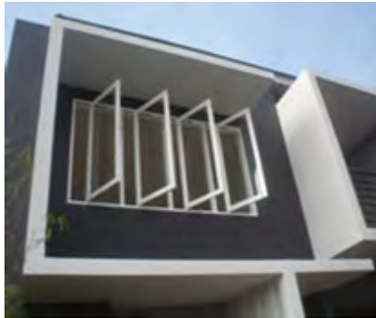
Gambar 7.16 Berkaitan dengan pemuaian, apa yang perlu diperhatikan saat merancang jendela seperti ini?
