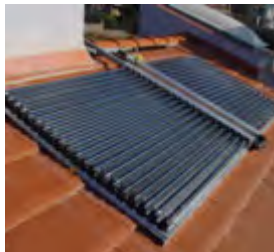
Gambar 8.27 Permukaan pemanas air yang memanfaatkan panas matahari (solar heating) berwarna gelap atau hitam. Mengapa?
