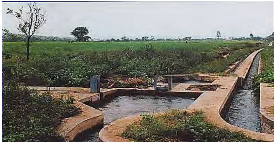
Gambar 5. Bangunan bagi dan sadap
