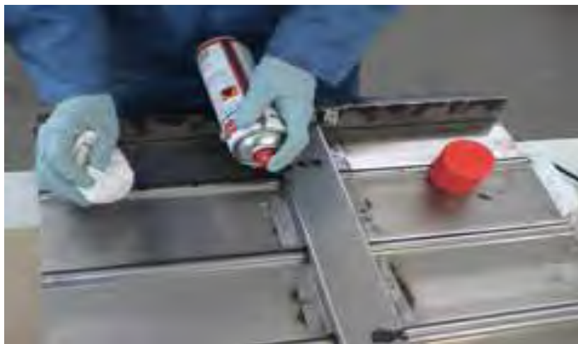
Gb.4.21. Pembersihan area pemasangan dengan semprotan pembersih/solvent
