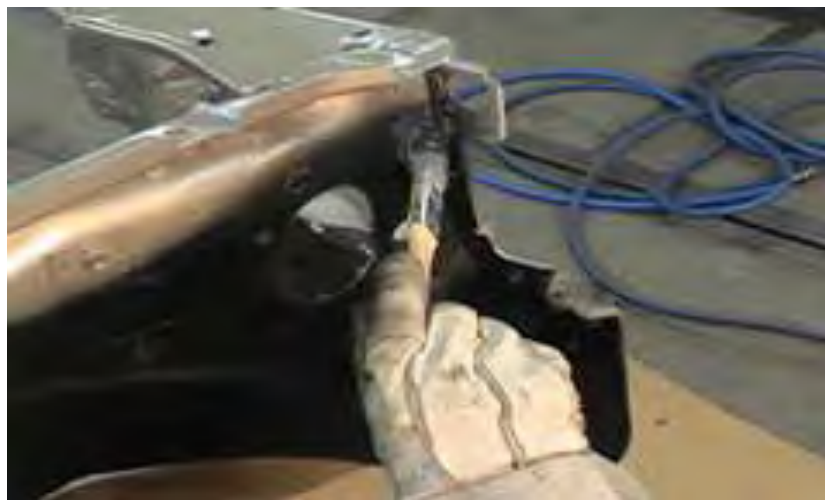
Gb.4.16. Penggunaan kuas untuk melapiskan brush-on sealant
