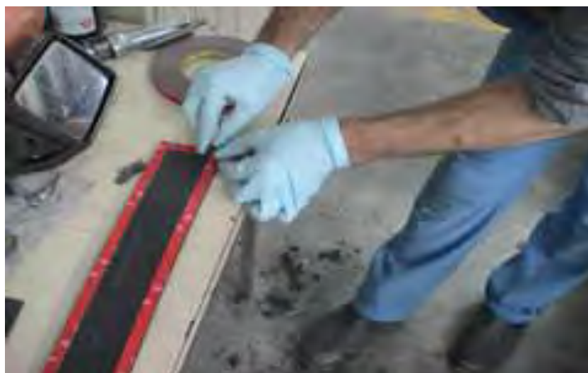
Gb.2.33. Pemasangan pita perekat pada keempat sisi dari bagian belakang moulding
